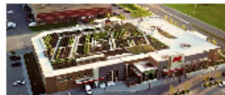
Alle de mange bygninger i de store byer giver store muligheder for grøntsagsdyrking. I Montreal har man anlagt en stor og omfattende grøntsagsproduktion.
